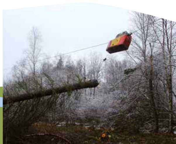
Photo 3 Les contraintes d'exploitation et la volonté de limiter l'impact des travaux, a conduit à utiliser la technique du câble-mât (● G.Rodier/ Pnr de Millevaches en Limousin)
