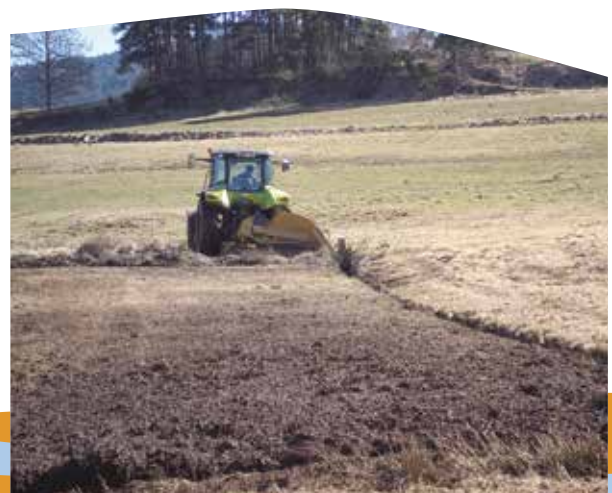
Photo 2 Rigolage sur la tourbière de Lissonat dans le sud des Monts du Forez (alt. 850 m). La superficie de la tourbière est modeste (0.22 ha) mais l'épaisseur de tourbe atteint 2.05 m dans la partie la plus profonde (● H. Cubizolle)
