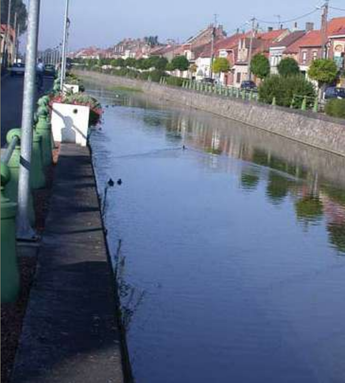
La canalisation réduit à néant l'espace de liberté des cours d'eau (canal de la Colme, 59). Photo B. Toussaint
