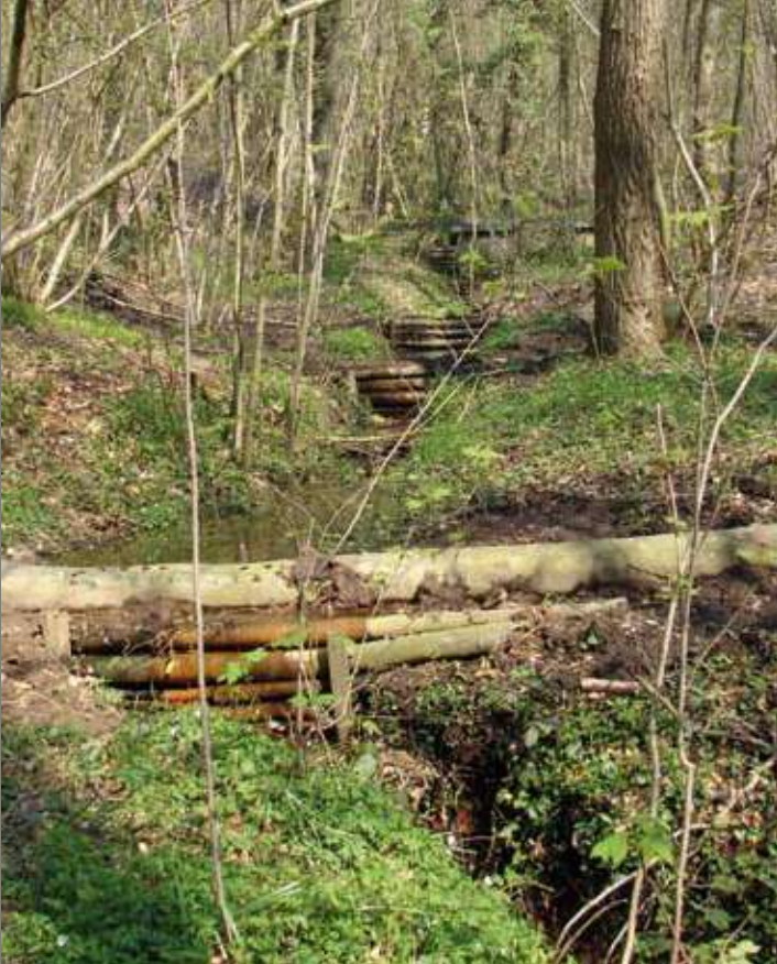
Mise en place de seuils dans un ruisseau forestier de la propriété départementale du Mont Noir. Photo B. Toussaint
